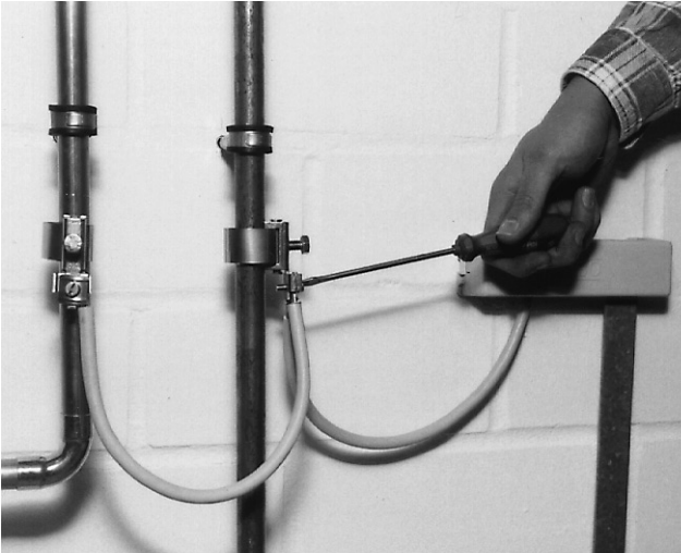
Bild 11 Solarkreis erden. Hierzu Erdungsrohrschellen an beiden Solarkreisrohren anbringen und über 6 mm 2 Kabel mit Potenzialschiene verbinden.
