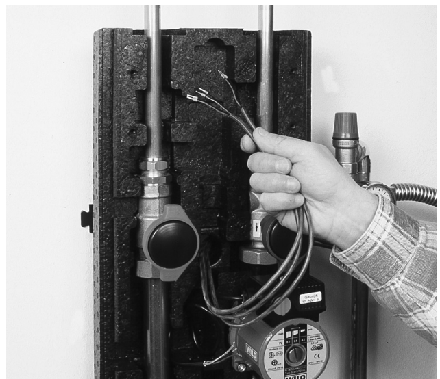
Bild 16 Fühlerkabel im Kabelkanal zur Solargruppe legen und durch Öffnung in der unteren Isolierschale nach vorne führen.
