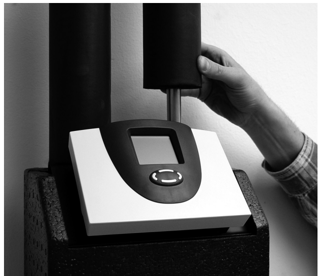
Bild 22 Zum Schluss Rohre des Solarkreises isolieren.
