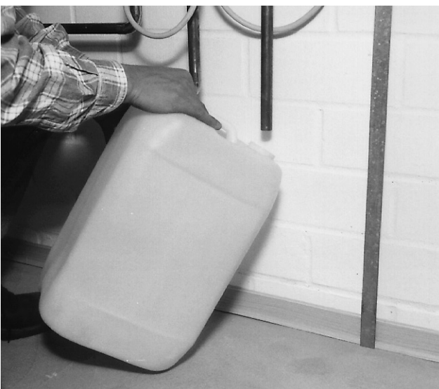
Bild 15 Abblaseleitung am Sicherheitsventil installieren und leeren DC20-Kanister zum Auffangen der Solarflüssigkeit unterstellen.
