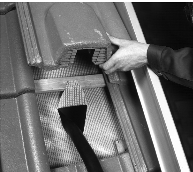
Bild 32 Unterspannbahn einschneiden, hochklappen, fixieren und Lüfterziegel einsetzen. Wellschläuche an Solarkreis anschließen und nach Abdrücken Rohrisolierungen bis an Kollektor ziehen.
