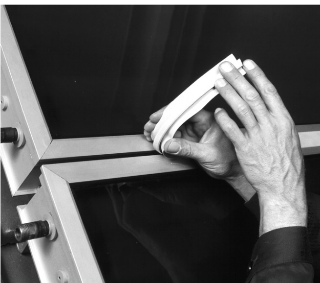
Bild 28 In die Spalte zwischen zwei Kollektoren Silikon-T-Profil einschieben oder drücken.
