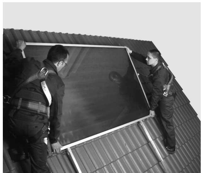
Bild 23 Kollektor an den unteren beiden Schraubbolzen auf den Montageschienen absetzen.
