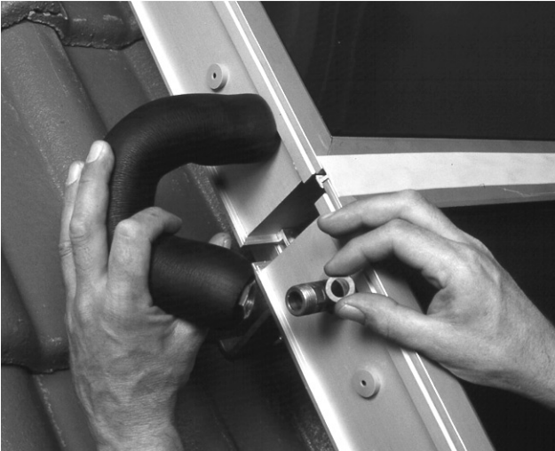
Bild 30 Kollektoren mit Edelstahlwellschläuchen verbinden. Auf Dichtungsringe achten
