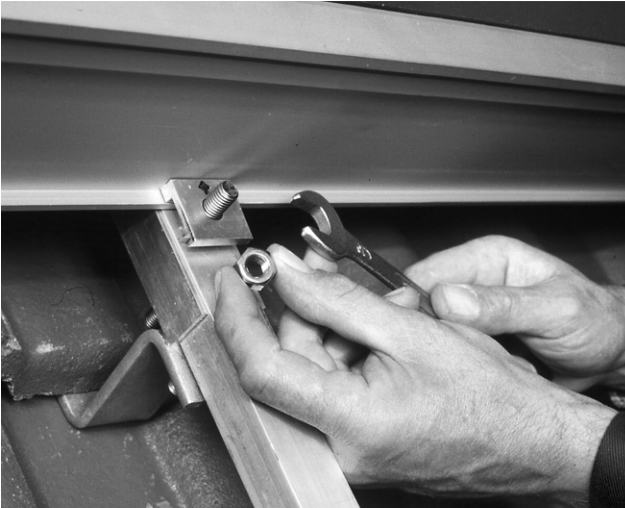
Bild 24 Den Kollektor an der Unterkante und Oberkante mit Befestigungsklemme so an Montageschiene fixieren, dass eingepprägter Pfeil zum Kollektor zeigt (s. Lupe 2).
