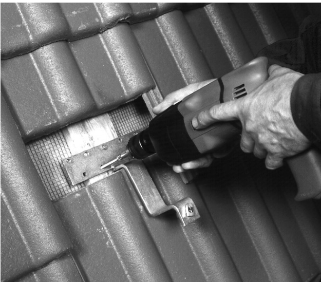
Bild 20 Sparrenanker mit Spax-Schrauben (6x80) befestigen. Wenn die Dachlatten stärker als 30 mm sind, dann die Sparrenanker entsprechend unterfüttern.
