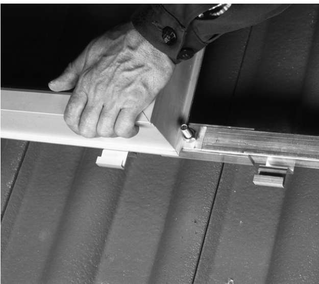
Bild 26 Nur bei senkrechter Anordnung zunächst Kollektoren in Aufdach-Kollektorhalter einsetzen.
