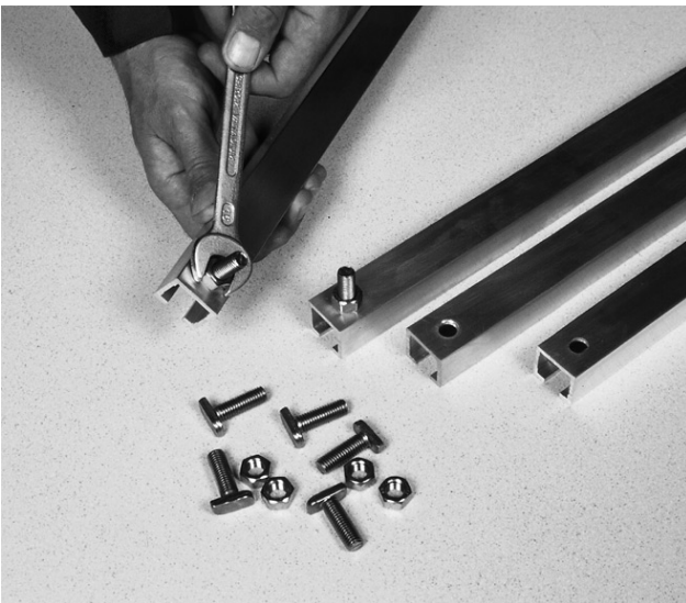
Bild 14 Montageschienen am Boden vorbereiten. Zunächst in alle Bohrungen der Montageschienen von der Innenseite Hammerkopfschrauben stecken und die Muttern festziehen.
