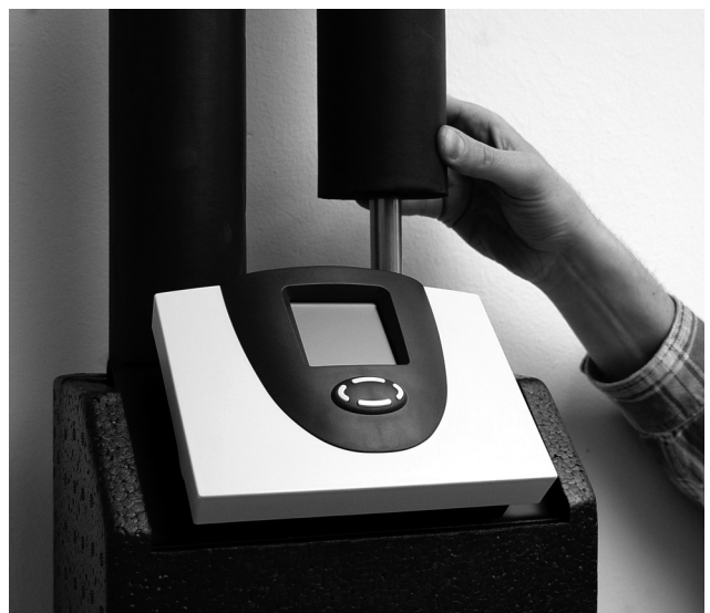
Bild 22 Zum Schluss Rohre des Solarkreises isolieren.
