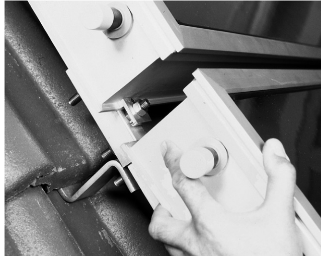
Bild 25 Unteren Kollektor mit der Oberkante unter Befestigungsklemme schieben und die unteren Befestigungsklemmen so festschrauben, dass Pfeil zum Kollektor zeigt.
