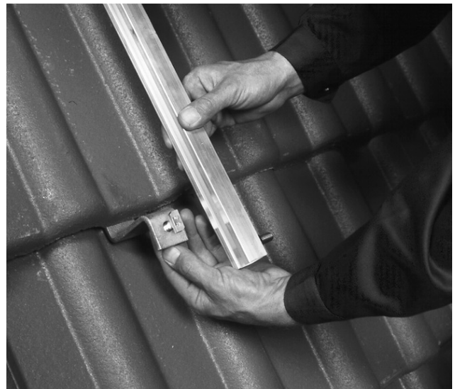
Bild 21 Montageschienen auf gleiche Höhe ausrichten und so mit Schrauben an Sparrenankern befestigen, dass der Hammerkopf beim Festziehen quer in der Schiene sitzt.
