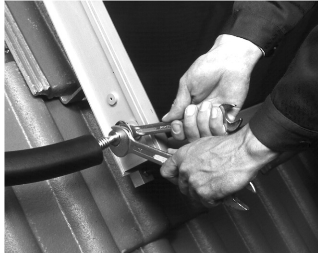
Bild 31 Gegenhalten beim Festziehen schützt Kollektoranschluss vor Schäden.
