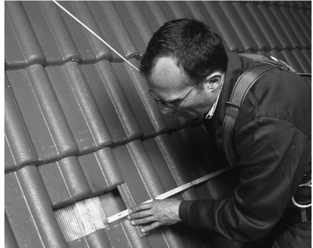
Bild 19 Kollektorfeld auf dem Dach ausmessen und entsprechende Befestigungspunkte auf den Sparren freilegen.
