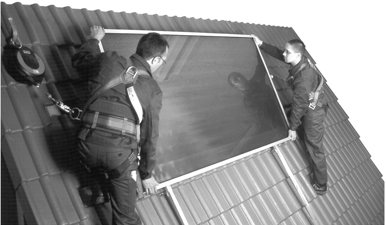
Bild 1 Die rapidosolar-Kollektoren können Sie mit dem Aufdachsystem gut zu zweit montieren ohne zu löten und ohne das Dach zu öffnen.
