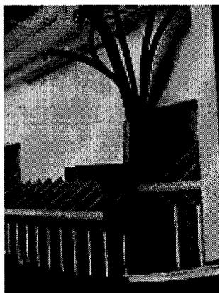
7. Hängen Sie das Gehäuse auf und verschrauben es an der Wand.
