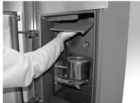
Bei Bedarf Flugasche vom Thermocontrol-Fühler entfernen. Der Thermocontrol-Fühler befindet sich im Brennraum hinter der Umlenplatte.
