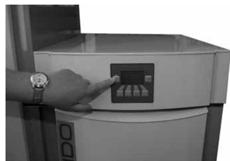
Komplettes Schaltfeld hochklappen und mit Sicherungsarm arretieren.
