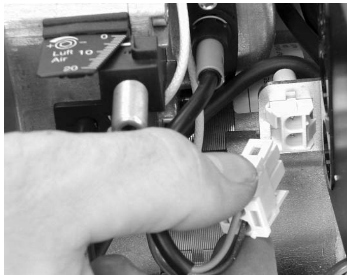
Abbildung 33 - Steckanschluß für Fotowiderstand Afb. 33 - Stekker van de fotoweerstand Figure 33 - Prise de raccordement pour la résistance photo-électrique
