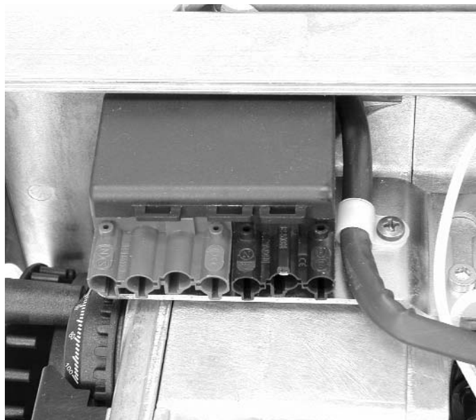
Abbildung 32 - Netzanschluß - Eurostecker Afb. 32 - Netaansluiting met de Eurostecker Figure 32 - Prise Européenne raccordement sur secteur
