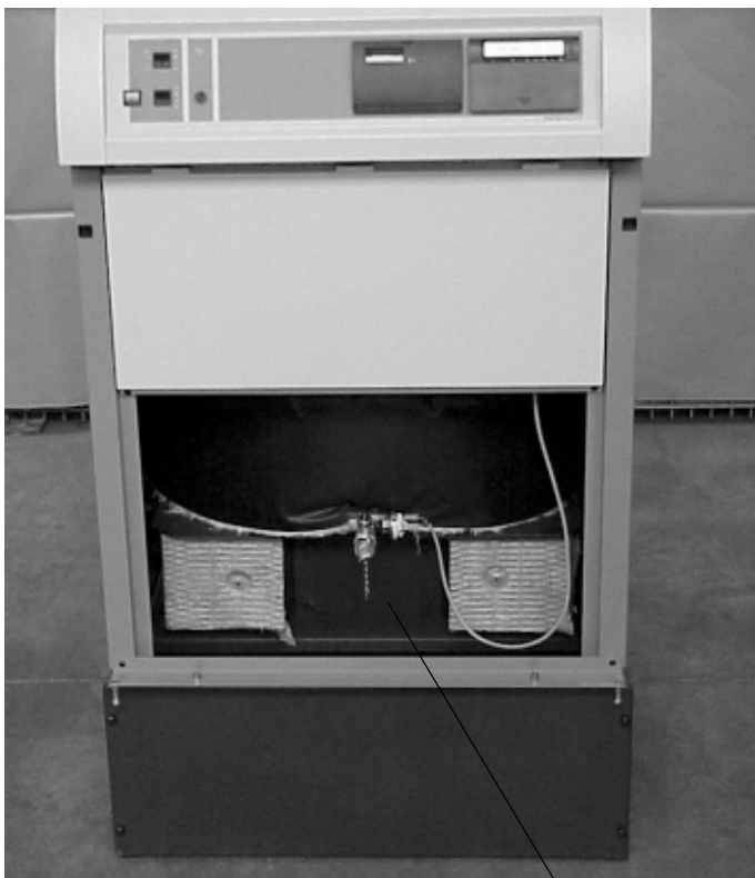
Abb. 16-5: Abnehmen des Gebläses mit Gasmischeinrichtung
