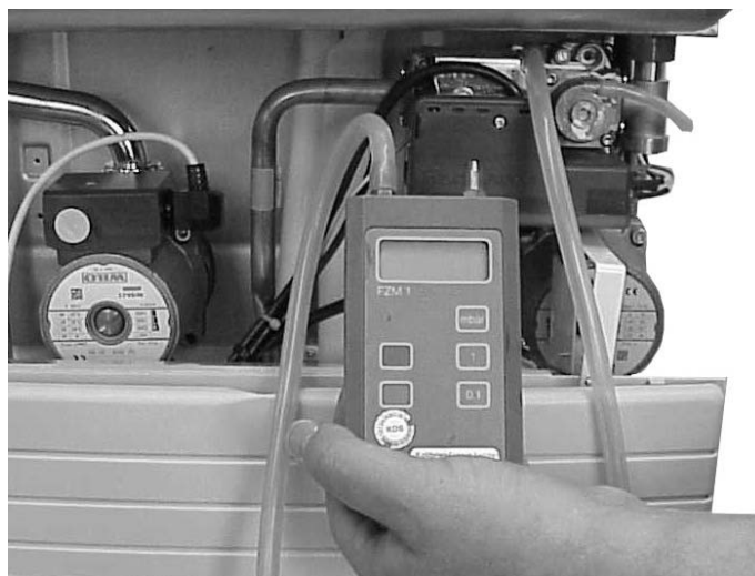
Fig. 5.12 Mesure de la pression du gaz
