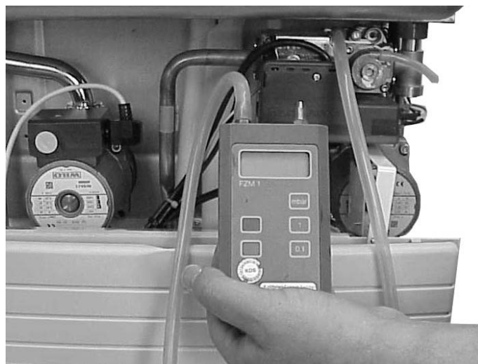
Abb. 5.12 Gasdruckmessung
