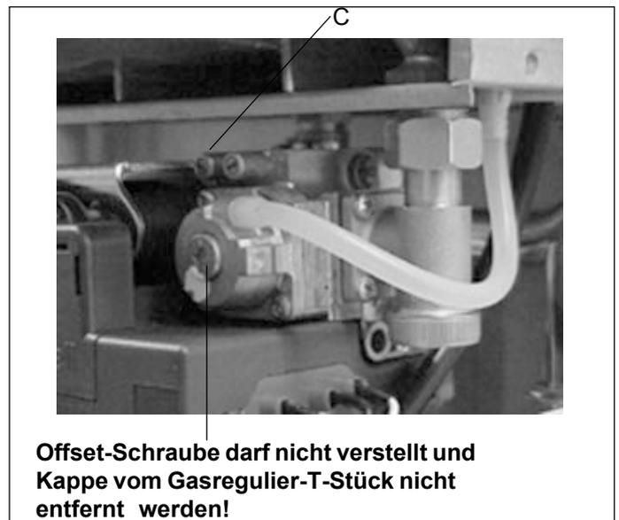
Abb. 11 Gasmagnetventil
